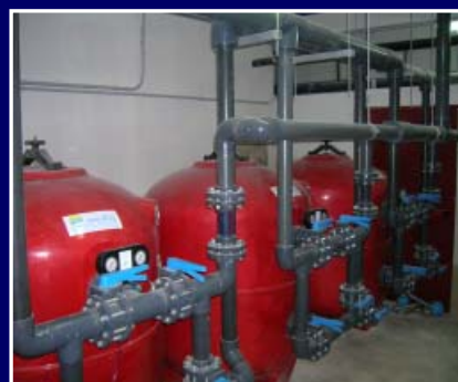
particolare impianto di filtrazione
